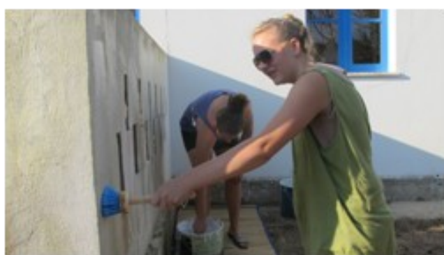
Muren bliver kalket
